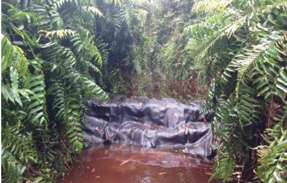
Dam dari tumpukan karung pasir adalah konstruksi yang umum untuk menutup kanal lama di RER guna mengembalikan tinggi muka air mendekati fluktuasi alaminya berdasarkan musim
