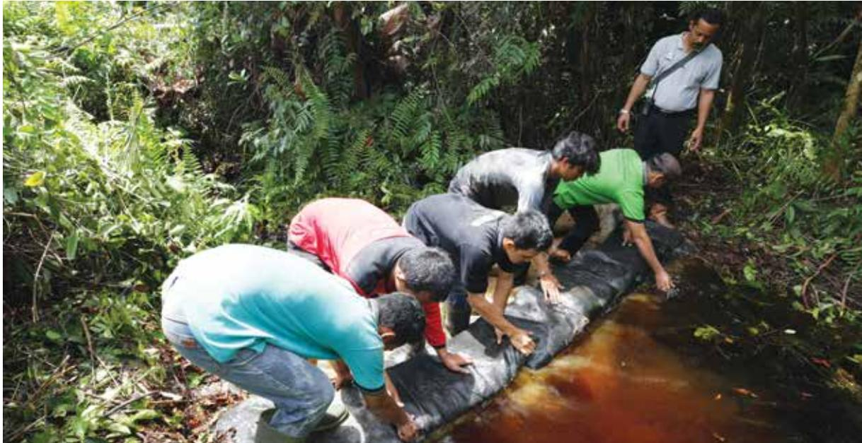
RER telah membangun 25 dam untuk menutup sembilan kanal lama sepanjang 29 km di dalam wilayah konsesinya
